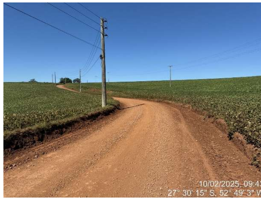
TRECHO 02 – INICIO (FOTO1) E FIM (FOTO 2)
